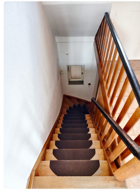
Treppe in OG
